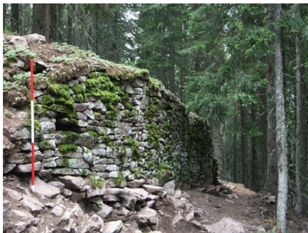
Обр. 2. Западната крепостна стена, външно лице – изглед от север. (Сн. Д. Дамянов).
