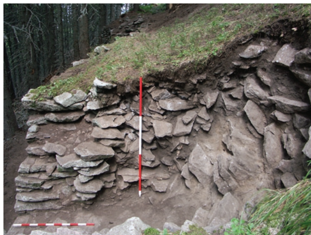
Обр. 3. Напречен разрез на западната стена, северна страна – изглед от юг. (Сн. Д. Дамянов).
